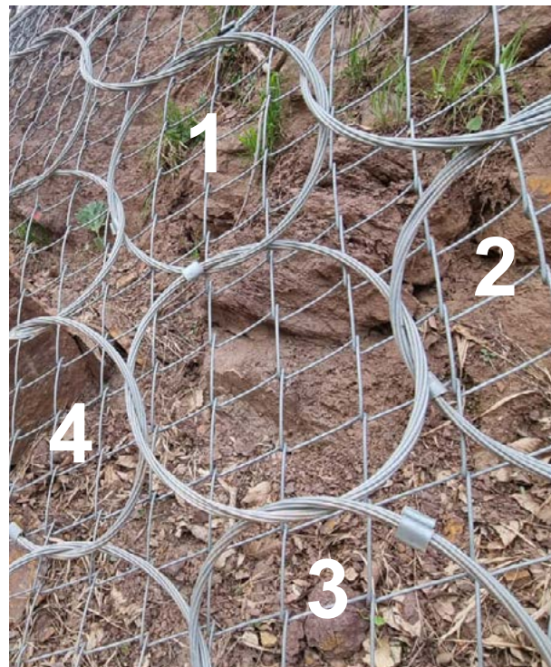
Четырехконтактное плетение кольчужных сетей: каждое кольцо вплетается в четыре соседних кольца.
