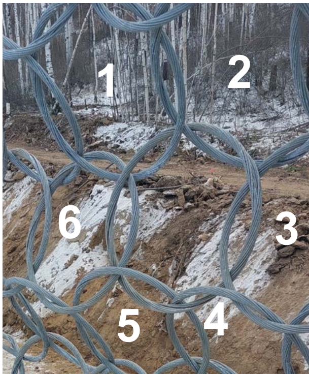
Шестиконтактное плетение кольчужных сетей: каждое кольцо вплетается в шесть соседних колец.
