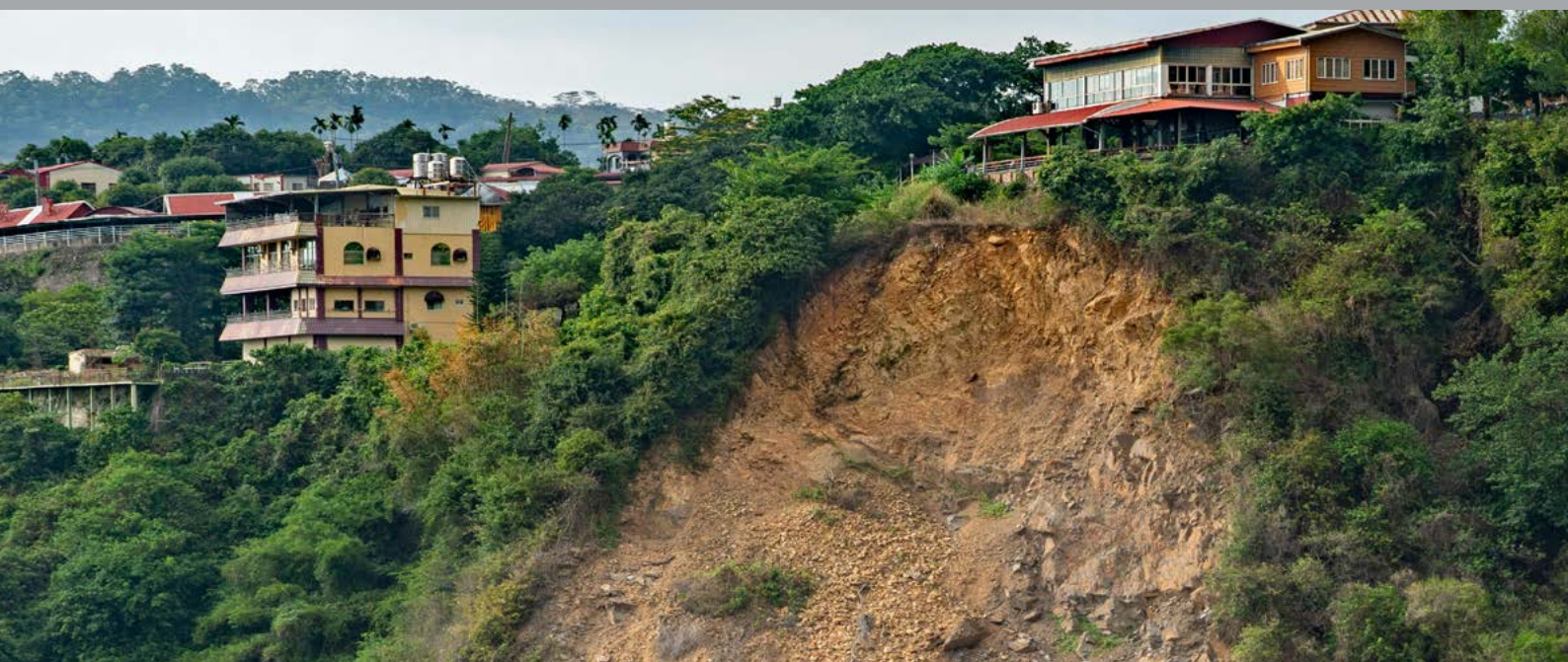
На фото: последствия оползня на о. Тайвань
